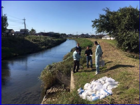
郷地落排水樋管付近
