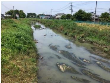
昨年の台風19号では郷地落排水樋管付近で護岸内に埋められている土嚢が溢水によりむき出しになり、樋管に逆流するなど県道行田蓮田線が一部水没しました。施行順序として、①工区を四郎兵衛橋(常光地区)から笠原大橋、②工区を笠原大橋から郷地橋、③工区を郷地橋から三谷橋に分けて施行者が決定し、護岸の嵩上げ前に樹木の伐採と土砂の撤去をおこないます。現在、梅雨前の渇水期では河川内に多くの土砂が堆積していることが分かります。土砂の撤去は9月末で完了し、堤防の嵩上げに移行する予定です。
