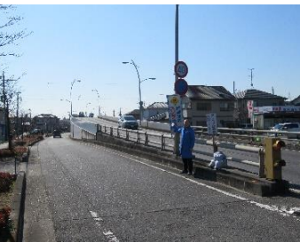
榛名陸橋 断面修復
