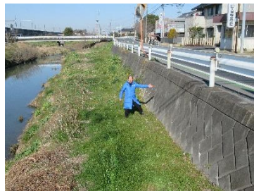
歩道設置のため測量調査
