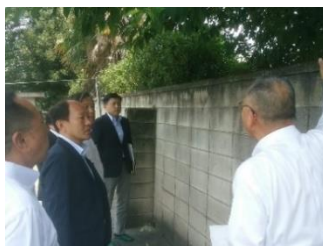
浦和商业高校 3, 4m以下の間隔で控え壁のないブロック塀
