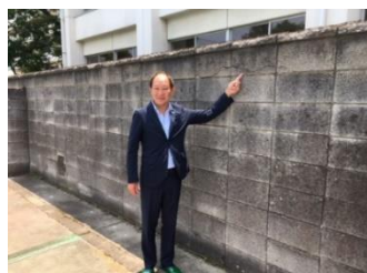
浦和商业高校 3, 4m以下の間隔で控え壁のないブロック塀
