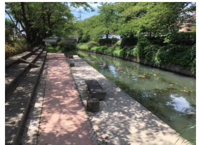
階段護岸と遊歩道
